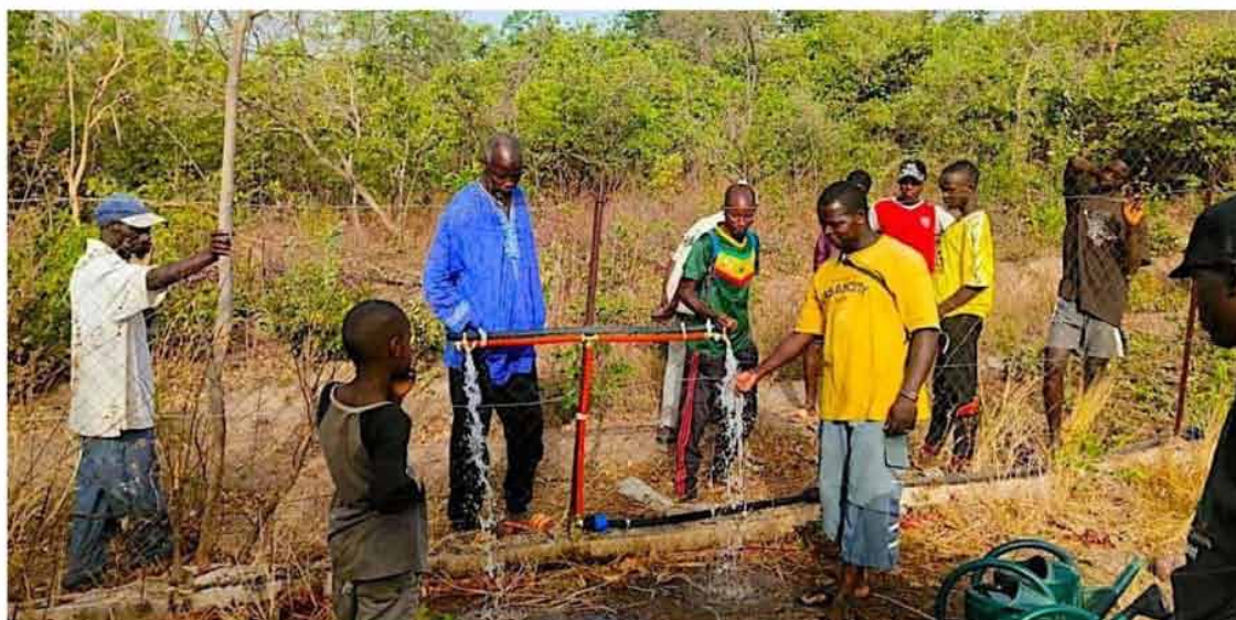
Obras en la aldea para llevar el agua
