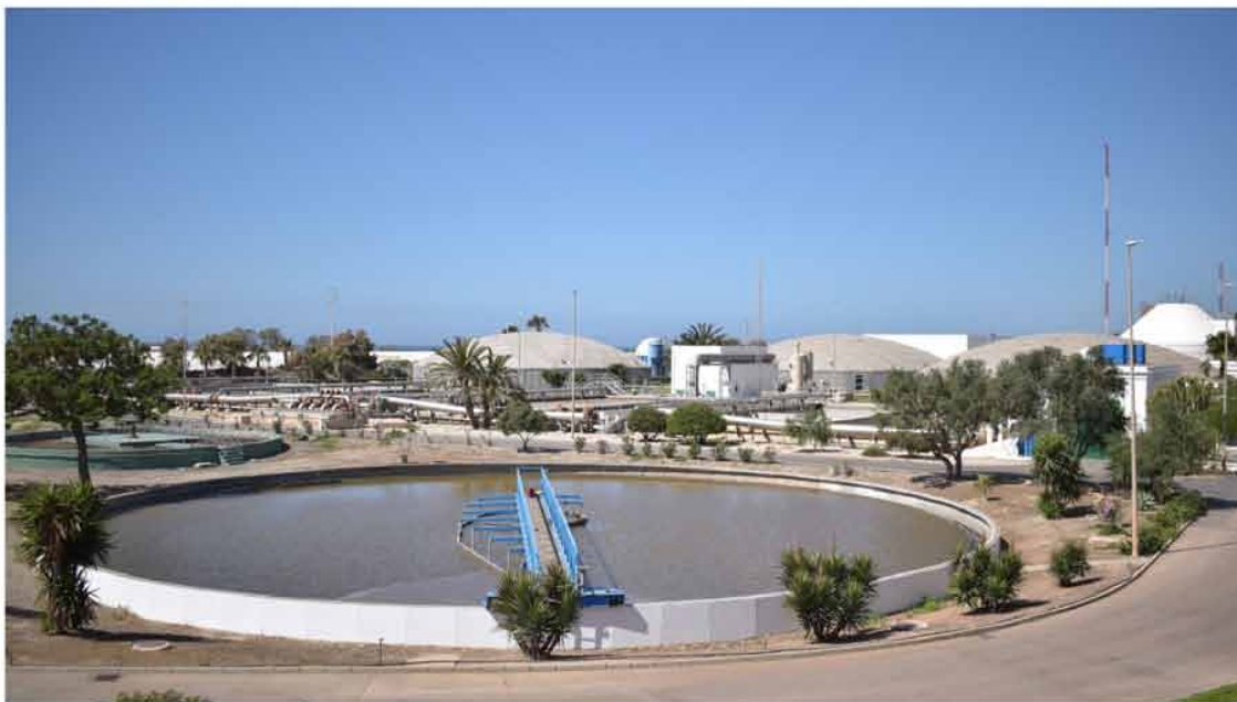
La instalaciones de la EDAR de El Bobar. La Voz
